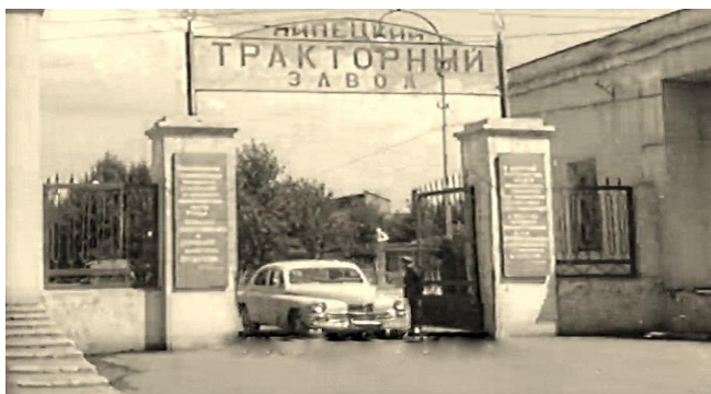
Проходные Липецкого тракторного завода
