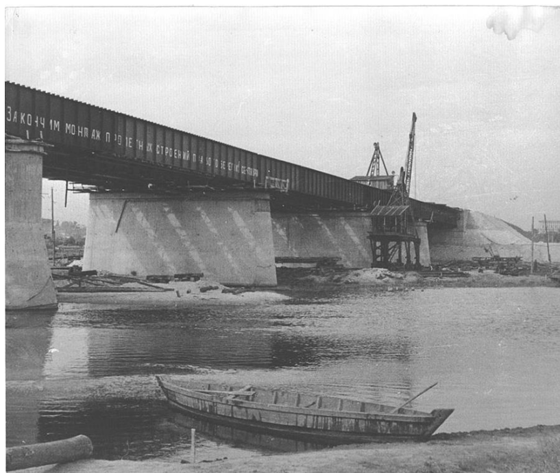
Строительство Петровского моста (1957 год)
